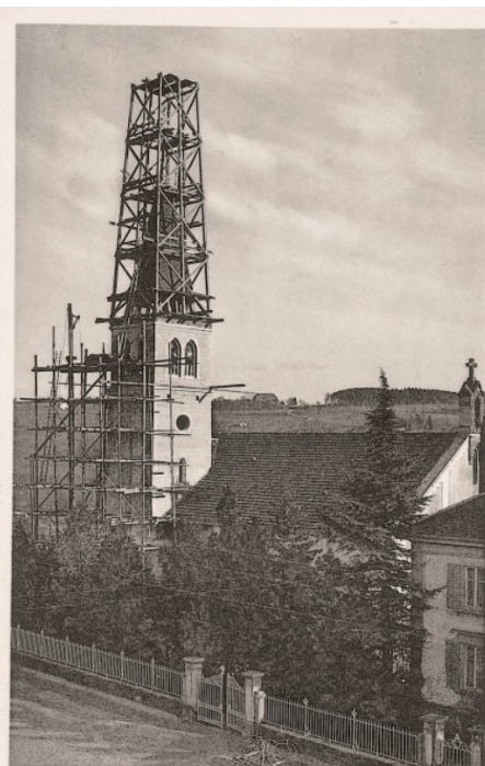
2080 MORAT - Construction du clocher de l'église catholique - MURTEN - Kirchturmbau
